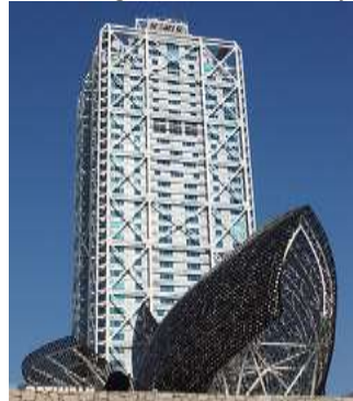
Moderna augstceltne ar ventilāciju
